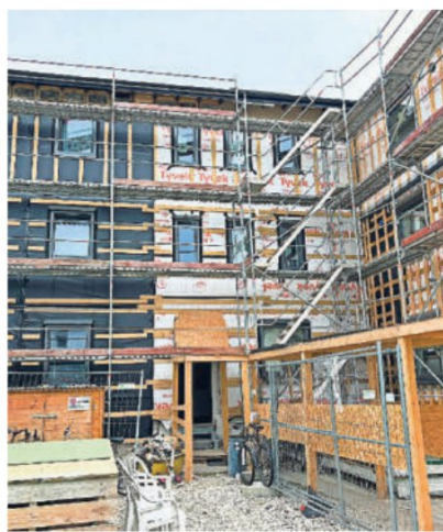
An das Bestandsgebäude wird derzeit ein Neubau (rechts im Bild) angeschlossen.
